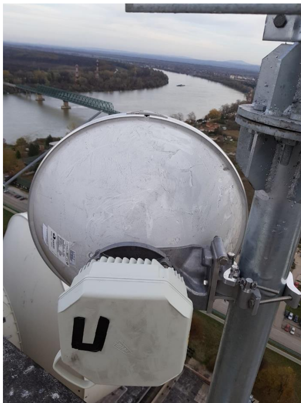
SLIKA 6. IZGLED POVEZIVANJE ODU JEDINICE I ANTENE
